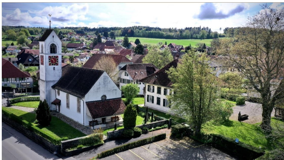
Die Kirche Rüti vor der Sanierung
